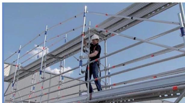
Deux types d'élément : le montant à poignée de déverrouillage et la lisse aluminium extensible en deux dimensions. La poignée de déverrouillage, actionnée en partie basse ou haute du montant, permet de desserrer les deux mâchoires et de monter ou descendre la protection d'un niveau, les lisses étant emboîtées sur les ergots à bascule du montant.
