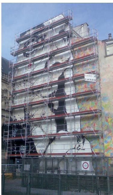
Layher est le créateur du système multidirectionnel à disque : **l'Universel... l'Original**. Il est constitué d'éléments linéaires, assemblés entre eux par clavetage.
