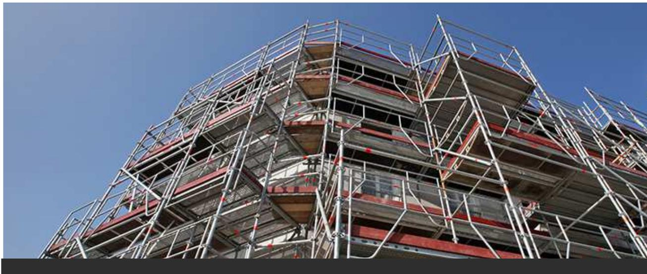
L'Échafaudage Universel LightWeight Galvanisé Layher est constitué par un système complet d'éléments linéaires, assemblés entre eux par clavetage. Il comprend :
