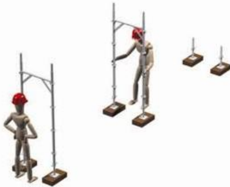
2 - Mise en place des portiques de plein pied sur les pieds à vérins Positionner le 2 ème portique à distance du module souhaité.
