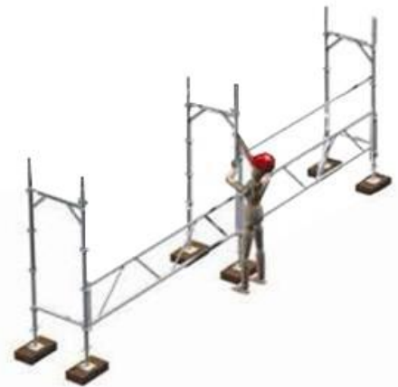
5 - Mise en place des longerons pour maille d'accès depuis le niveau 0 pour niveau N+1
