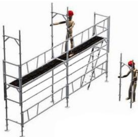
8 - Mise en place des garde-corps standard pour le niveau N
