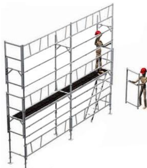
9 - Mise en place des garde-corps de montage et d'exploitation (longitudinale et d'extrémité) sur tout le niveau N
