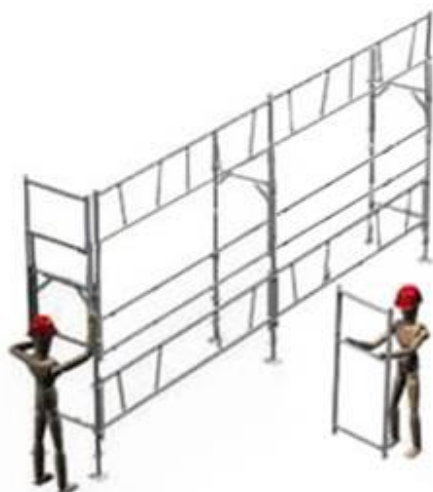
6 - Mise en place des garde-corps d'extrémité monobloc depuis le niveau 0 pour le niveau N+1
