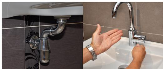
Un lavabo accessible présente un vide en partie inférieure d'au moins 0,30 m de profondeur, 0,60 m de largeur et 0,70 m de hauteur permettant le passage des pieds et des genoux d'une personne en fauteuil roulant. Le choix de l'équipement ainsi que le choix et le positionnement de la robinetterie permettent un usage complet du lavabo en position assise en veillant notamment à la facilité de leur préhension.
