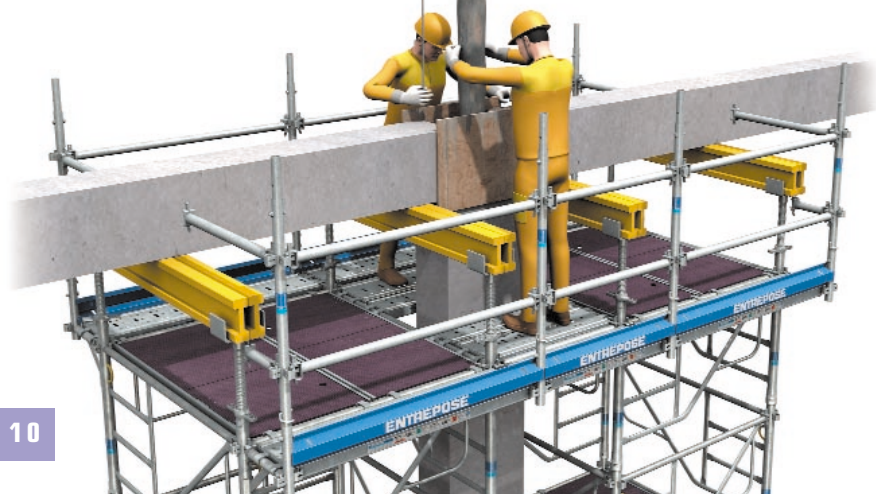
1 Le montage du platage s'effectue en sécurité depuis un niveau de plancher en position provisoire.
