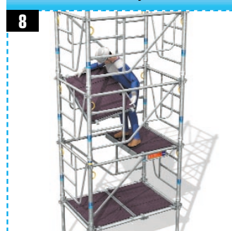
8 • Déplacement du premier plancher à trappe.
