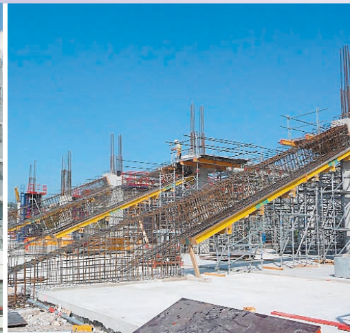
Étaisements pour la construction du Stadium de Nice.
