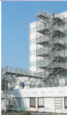
Escalier et passerelle public à la clinique de St-Louis (68).
