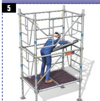
5 • Pose du premier plancher à trappe de 1,00 m.
