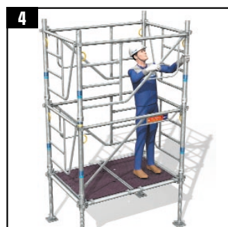
4 • Pose de 2 planchers à trappe de 1,00 m et montage du second niveau.
