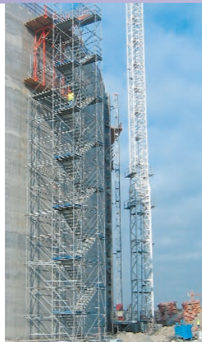
Escalier de service sur bac de stockage à Fos-sur-Mer.
