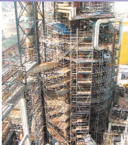
Échafaudages pour les travaux d'arrêt de la raffinerie Total de Fos-sur-Mer.
