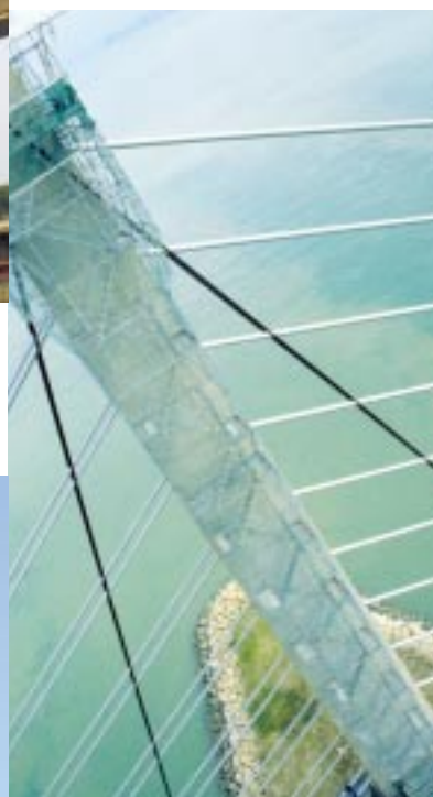
Accès de grande hauteur Pont de Penang.
