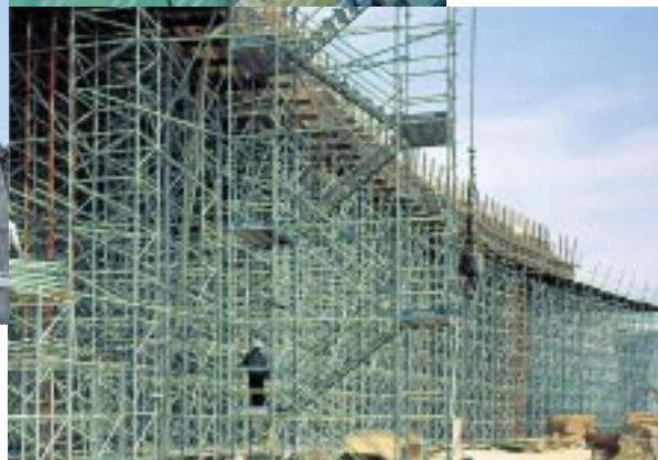
Escaliers d'accès Travaux Publics La compatibilité des matériels Crab permet le liaisonnement des escaliers aux tours d'étaie sans utiliser de tubes et raccords.
