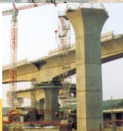
Tours escaliers Accès pour chantiers Travaux Publics.
