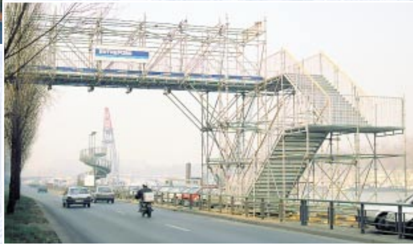
Passerelle simple sur palées MultiCrab
