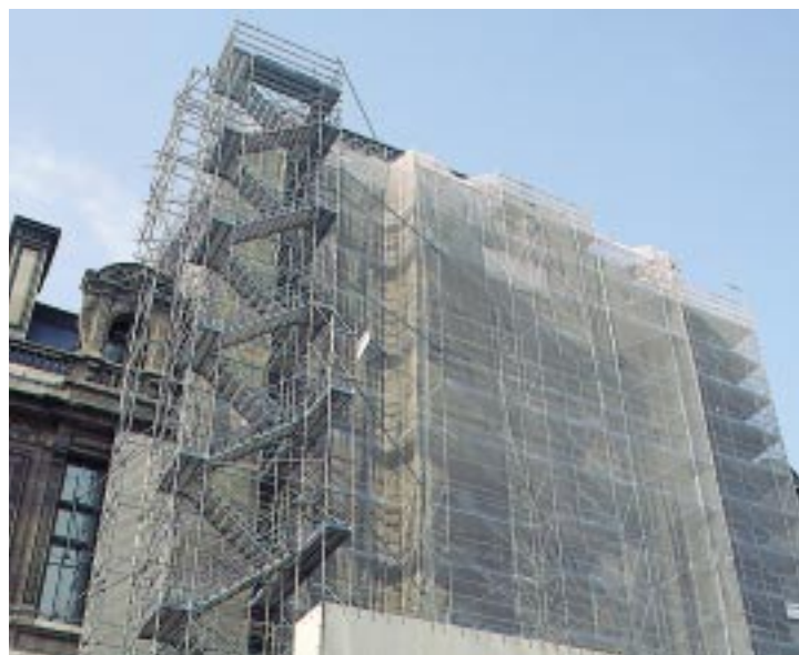
Escaliers d'accès Bâtiment Sapine d'accès sur échafaudage de service.
