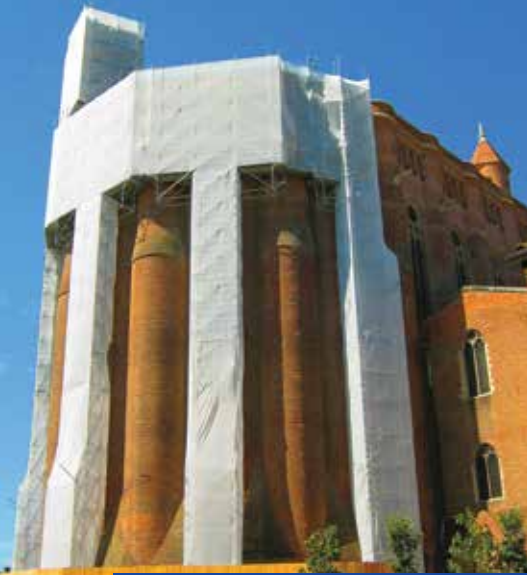
Cathédrale d'Albi : échafaudages pour la restauration du couronnement et des vitraux.
