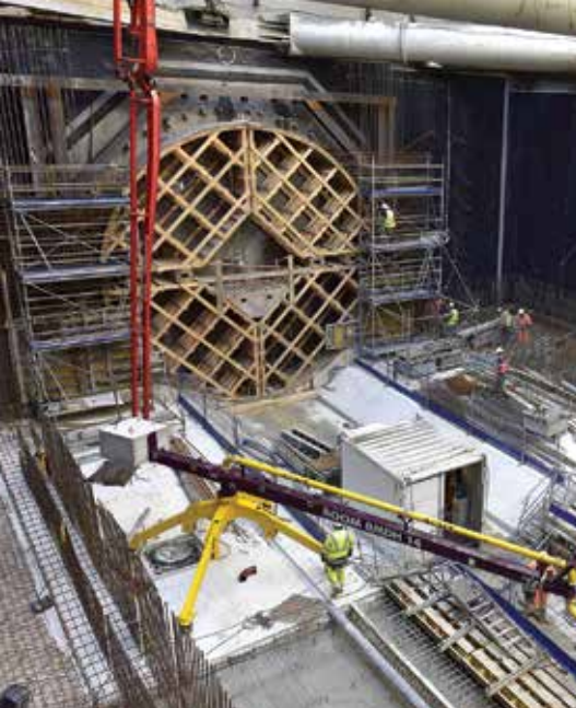
Métro de Rennes : échafaudages de service et étaielements à la station "Gares".
