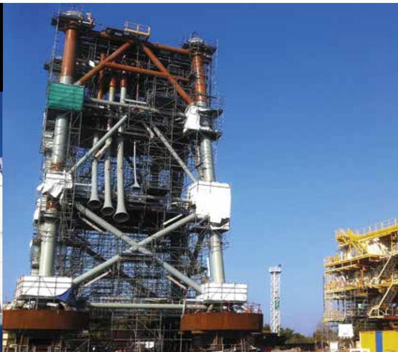
Fos-sur-Mer : échafaudages pour la construction des modules de la plateforme offshore "Anguille".
