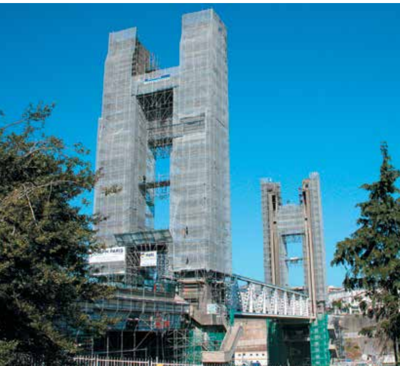
Brest : échafaudages et étaielements pour les travaux de transformation du pont de Recouvrance.
