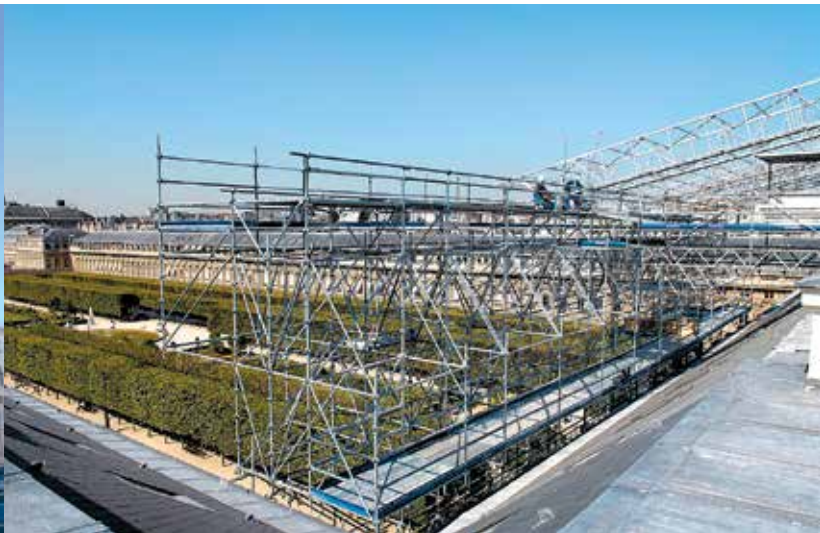
Palais Royal à Paris : parapluie pour les travaux de rénovation du siège de la Banque de France.
