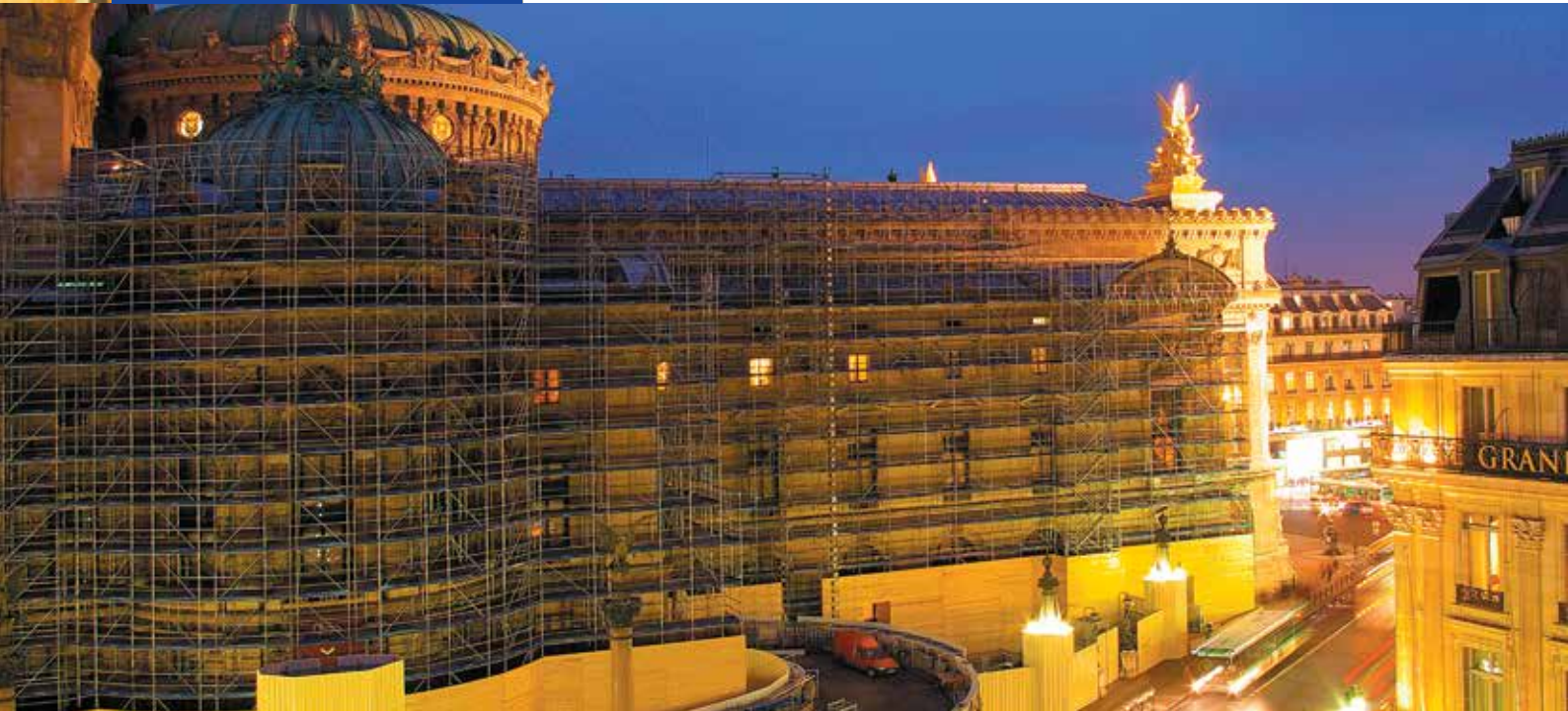
Opéra Garnier : échafaudages pour la restauration de la façade ouest et de la rotonde.
