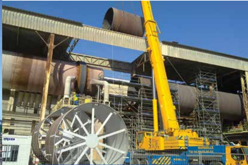
Ciments Lafarge : échafaudages et étaie pour changement d'une virole de four.
