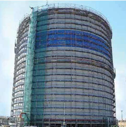
Fos-sur-Mer, site de GDF : échafaudage d'un réservoir Ø 40 m.
