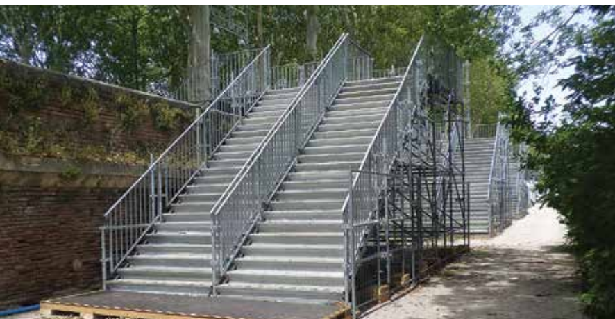
Toulouse : escaliers publics pour accès supplémentaires provisoires durant le festival "Rio Loco".
