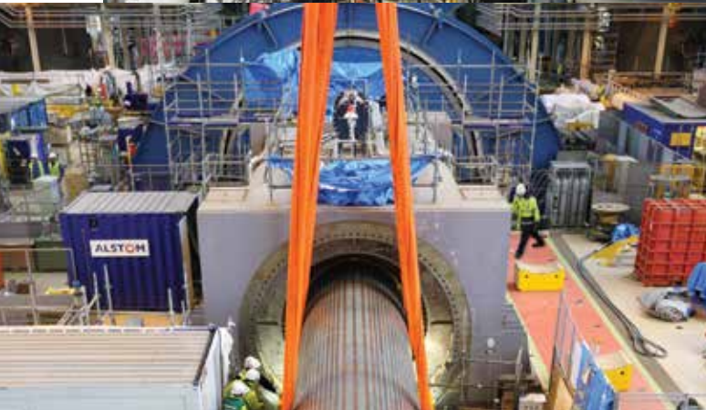
EPR de Flamanville : une multitude d'échafaudages et d'étaieements sur ce chantier depuis son démarrage.
