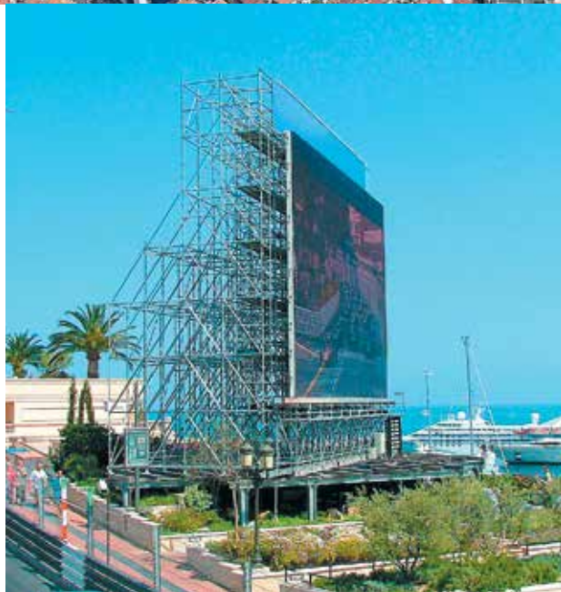
Monaco : pour le Grand Prix de F1, tribunes et échafaudages connexes tels que les passerelles, les escaliers d'accès et les supports d'écrans géants.
