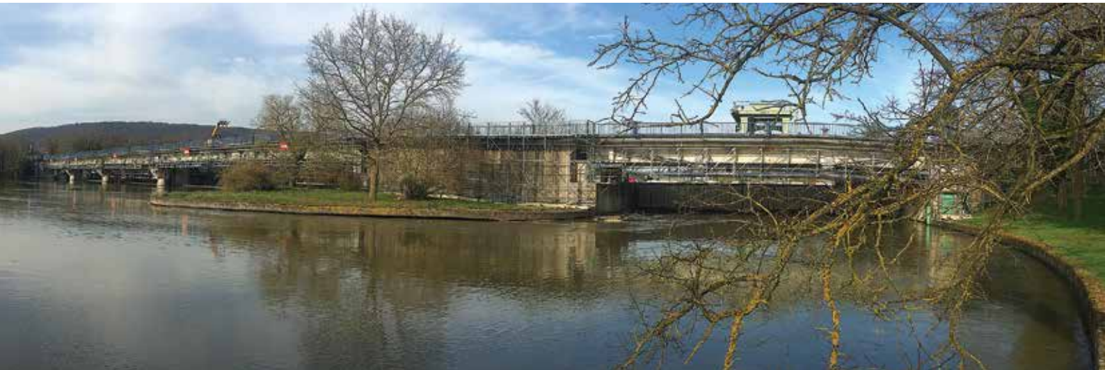
Barrage de Jouy-aux-Arches : échafaudages suspendus et passerelles publiques.
