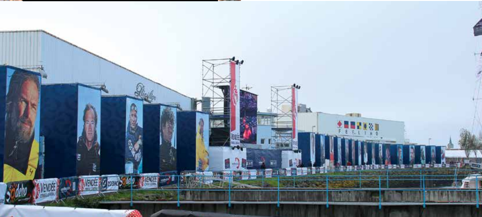
Les Sables-d'Olonne, course du Vendée Globe : mur d'échafaudage de 180 m de longueur, composé de "tours totems" supportant les portraits des navigateurs.
