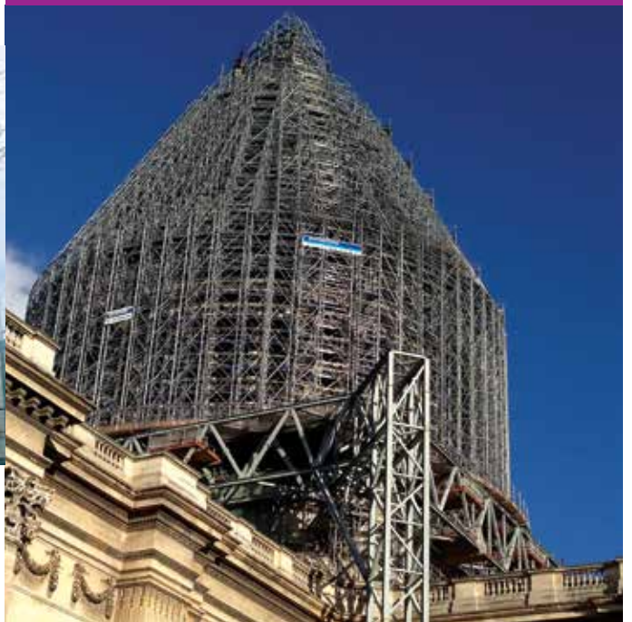
Le Panthéon à Paris : échafaudage de 450 tonnes, sans appui sur le monument, pour la restauration du lanterneau, du dôme et du tambour.
