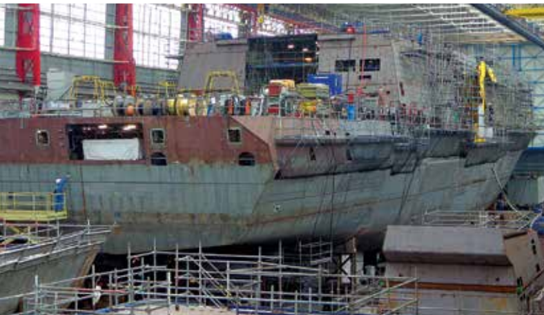
DCNS Brest : échafaudages pour la construction des frégates FREMM.
