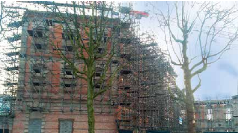
Lille : étaielements des façades de l'ancien hôpital Saint-Antoine
