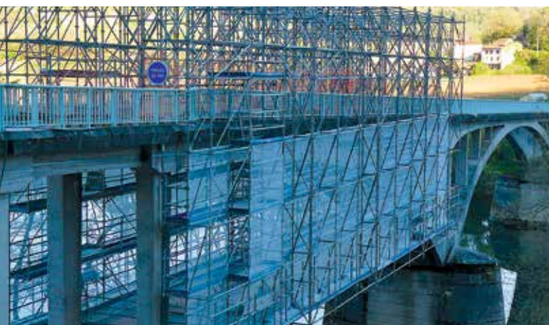
Pont d'Arcambal (46) : échafaudages roulants pour travaux de rénovation.
