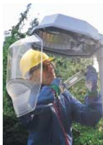
Les lampes à décharge ont pour caractéristiques une excellente efficacité lumineuse, une durée de vie élevée et un indice de rendu des couleurs qui permettent de répondre à des besoins de mise en lumière variés aussi bien en intérieur - *magasins par exemple* - qu'en extérieur - *l'éclairage routier*.
