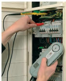
*Contrôle d'isolement sur tableau domestique (installation hors tension) entre phase et terre avec le DT-500 (Réf. DT-500).*
