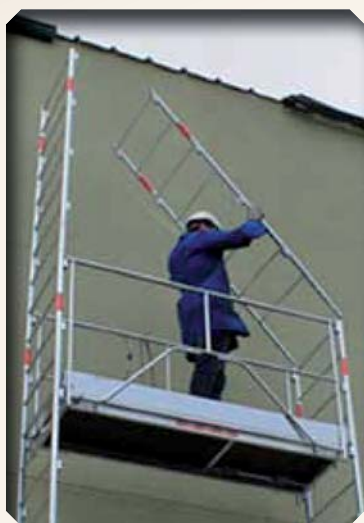
1. Mise en place des échelles
