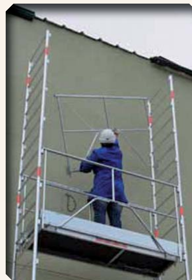
2. Mise en place des garde-corps
