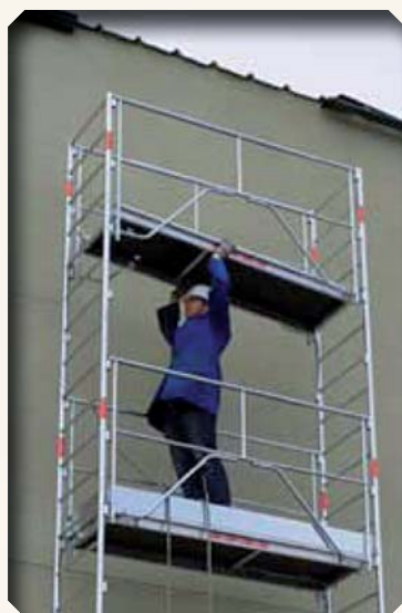
3. Mise en place du plancher
