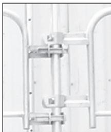
Détail de l'assemblage des GC sur les Echafrans pour bon alignement des lisses et sous-lisses.
