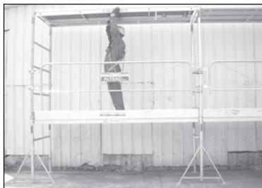
7. A partir de ce premier niveau sécurisé, installer les planchers du 2ème étage, dont un avec la trappe. Mettre en place les anti-soulèvements.
