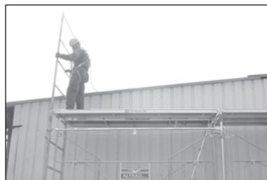
11. Emboîter dans l'échelle d'extrémité un Echafran barreaux fixes (ou Echafran export avec 2 barreaux/lisses, ou GC latéral/cadre Z + collier entretoise placé côté intérieur de l'échafaudage).
