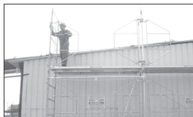
13. Installer dans chaque travée 2 cadres Z (lisses supérieures entre 1m et 1.10m au dessus du plancher), à l'aide des colliers à clavettes.
