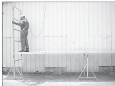
3. Emboîter dans le tréteau d'extrémité un Echafran barreaux fixes (ou Echafran export avec 2 barreaux/lisses, ou GC latéral/cadre Z + collier entretoise placé côté intérieur de l'échafaudage).
