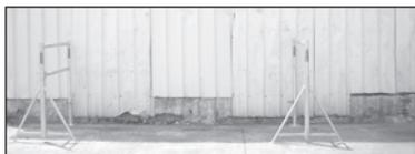
1. Installer sur leurs calages les tréteaux, platines femelles côté mur, à des intervalles de 3m (longueur des planchers et des GC fixes).
