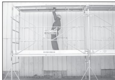
7. A partir de ce premier niveau sécurisé, installer les planchers du 2ème étage dont un avec la trappe côté mur. Mettre en place les anti-soulèvements.
