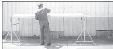
2. Installer sur les tréteaux les planchers préfabriqués (3 de largeur 300 ou 1 largeur 600 alu/bois + 1 largeur 300). Mettre de niveau. Régler le bord du plancher à 20cm maximum du mur. Mettre en place les anti-soulèvements.
