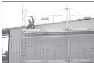
15. Poser les plinthes longitudinales (3m) à l'aide des pattes dans les planchers et les plinthes latérales (0.90m) à l'intérieur des Echafrans à l'aide des U dans les montants.
