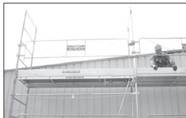
14. Procéder à l'installation des plinthes longitudinales (3m) à l'aide des pattes dans les planchers et les plinthes latérales (0.90m) à l'intérieur des Echafrans à l'aide des U dans les montants.
