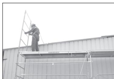
11. Emboîter dans l'échelle d'extrémité un Echafran barreaux fixes (ou Echafran export avec 2 barreaux/lisses, ou GC latéral/cadre Z + collier entretoise placé côté intérieur de l'échafaudage).
