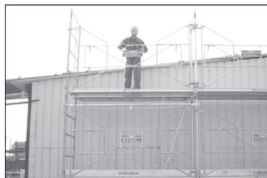
14. Procéder à l'installation du cadre rectangulaire sur les 2 cadres Z avec réglage de la verticalité des Echafrans au serrage des colliers à clavettes 2 à 2.
