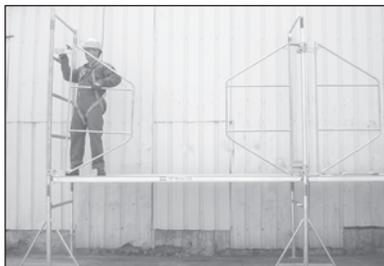
5. Fixer sur les montants de chaque travée 2 cadres Z (lisses supérieures entre 1m et 1.10m au dessus du plancher), à l'aide des colliers à clavettes (cf. détail).
