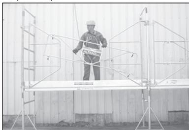
6. Procéder à l'installation du cadre rectangulaire sur les 2 cadres Z avec réglage de la verticalité des Echafrans au serrage des colliers à clavettes 2 à 2. Poser les plinthes longitudinales (3m) à l'aide des pattes dans les planchers et les plinthes latérales (0.90m) à l'intérieur des Echafrans à l'aide des U dans les montants.
