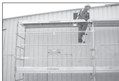
10. Accéder à l'étage supérieur à l'aide de l'échelle d'accès en passant par la trappe. Toujours équipé d'EPI.
