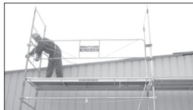
13. Installer dans chaque travée (lisses supérieures des GC entre 1m et 1.10m du plancher), les GC fixes à l'aide des colliers à clavettes. Mettre de niveau.
