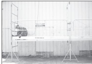
6. Procéder à l'installation des plinthes longitudinales (3m) à l'aide des pattes dans les planchers et les plinthes latérales (0.90m) à l'intérieur des Echafrans à l'aide des U dans les montants.
