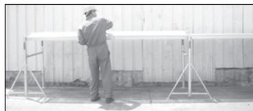
2. Installer sur les tréteaux les planchers préfabriqués (3 de largeur 300 ou 1 largeur 600 alu/bois + 1 largeur 300). Régler le bord du plancher à 20cm maximum du mur. Mettre en place les anti-soulèvements. Mettre de niveau.
