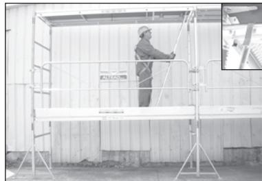
8. Accrocher l'échelle d'accès à l'aide de ses deux crochets sur la traverse du plancher à trappe en soulevant cette dernière (cf. détail).
